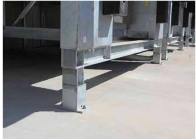
Bolzenanker BZ3 A4
